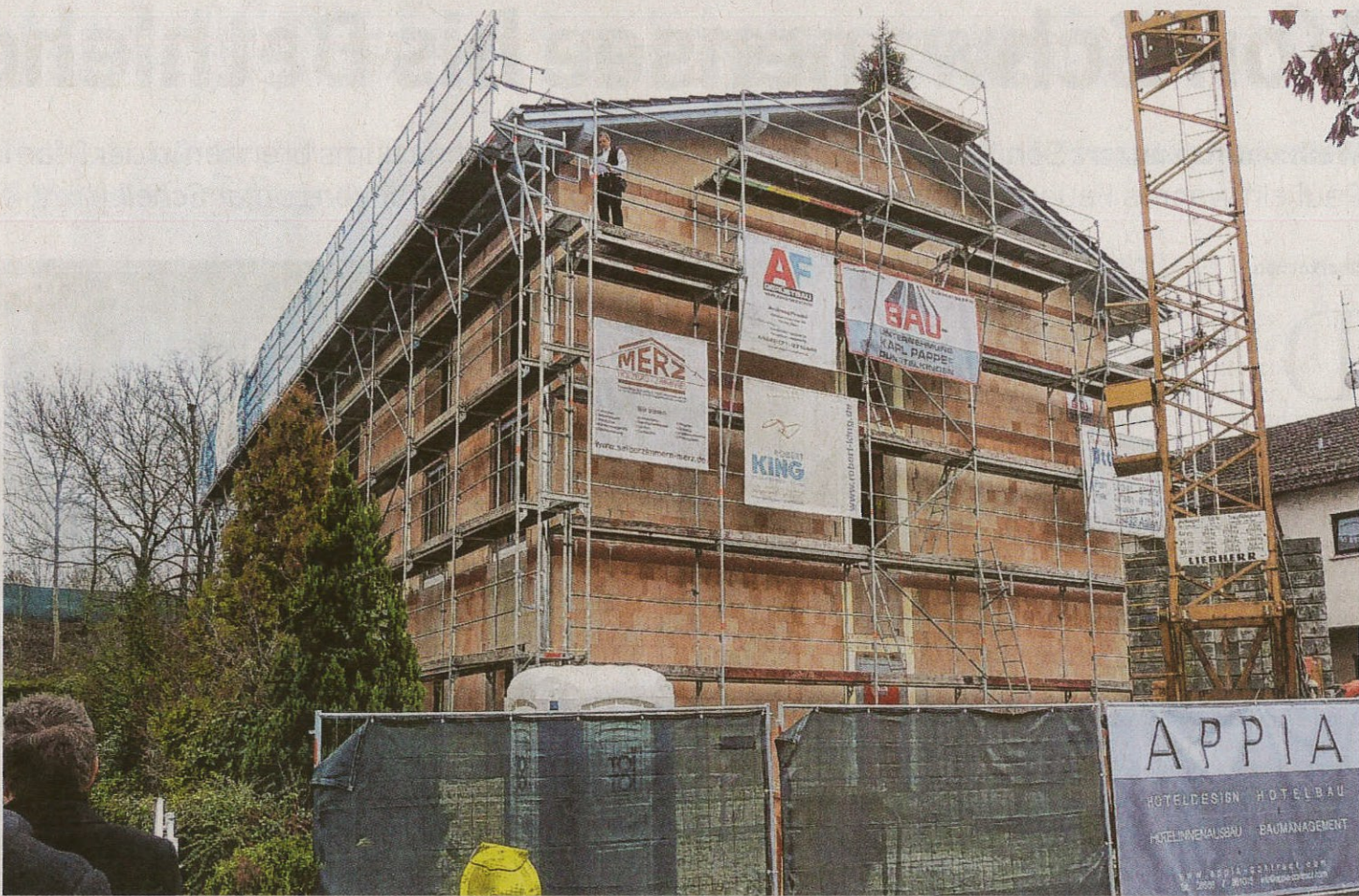
Hotelneubau „Wilder Mann“: Zimmerermeister Florian Merz steht auf dem Baugerüst und bringt den Richtspruch aus.
